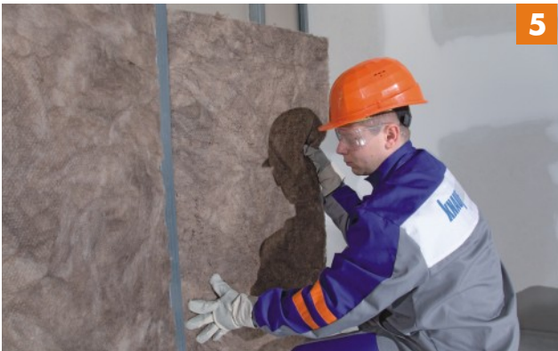
Aplicarea izolației minerale pe cadrul pregătit, introducere cu ușoară presiune
