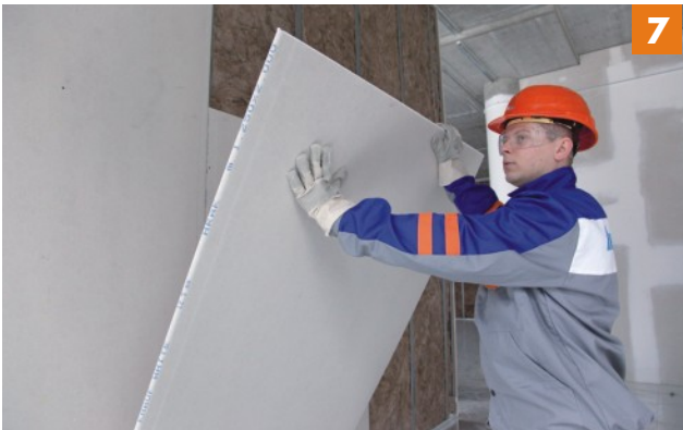
Montarea celui de-al doilea strat de gips carton pe structură (ex. Knauf A13) , cel de-al doilea strat trebuie să acopere îmbinările plăcii primului strat
