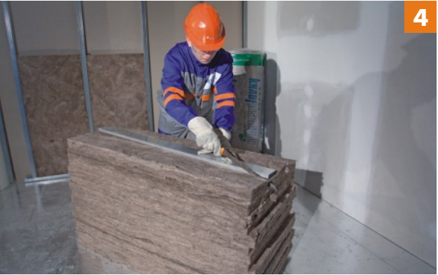
Tăierea unei secțiuni predeterminate de izolație minerală pentru o distanță care nu este standard
