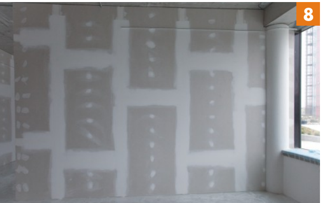
Etapa finală este aplicarea masei de șpaclu pe îmbinările plăcii și capetele șuruburilor de fixare
