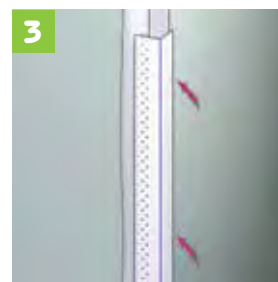
3 Se aplică un strat subțire de ipsos de îmbinări și se lipește banda cu fața către colț
